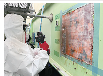
山鹿大橋(熊本県)でのレーザークリーナーによる塗膜除去
