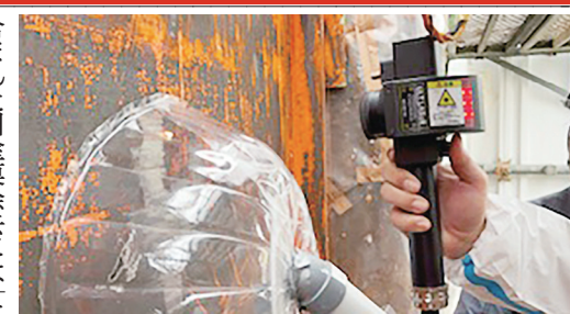
レーザークリーナー作業中、JLC工法で安全性向上
