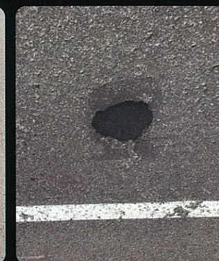
車道ポットホール補修
