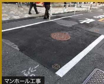
マンホール工事
